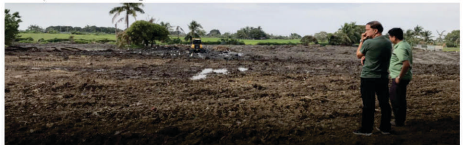
Tinatanaw ni Maragondon Mayor Umbe Arca at isang kasamang opisyal ng pamahalaang lokal ang proyektong access road mula BNIS papuntang Bypass road sa Brgy. Bucal 2.
